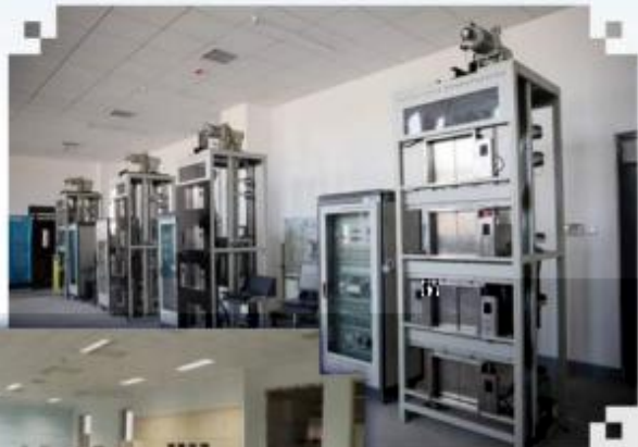
智能电梯安装调试 维护训练场所
